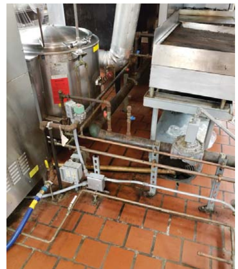
Image 2 - Excessive Conduit
